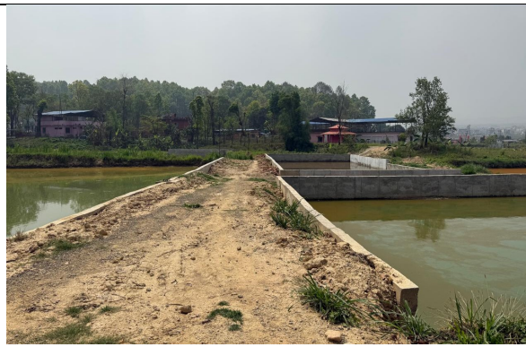
नर्सरी पोखरी १,२ र माउ पोखरी ६,७ मा RCC wall निर्माण
