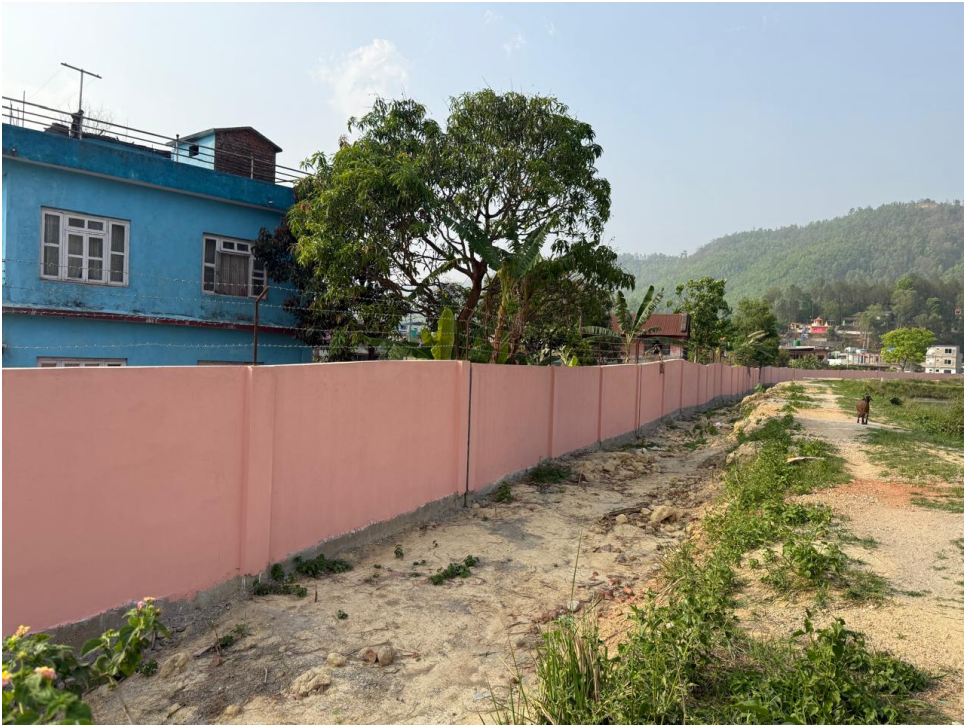
फार्मको अतिक्रमण रोक्न तथा सुरक्षाको लागि boundary वाल निर्माण
